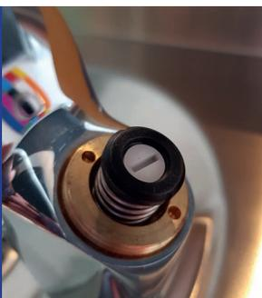
Drehen Sie die weiße Regulierschraube mit einem Schlitzschraubenzieher gegen den Uhrzeigersinn, um den Wasserdurchfluss zu verringern, oder im Uhrzeigersinn, um den Wasserdurchfluss zu erhöhen
